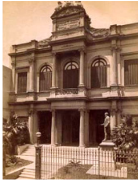
Frente del edificio de la calle Moreno 353 Primer edificio propio de la Facultad de Derecho
