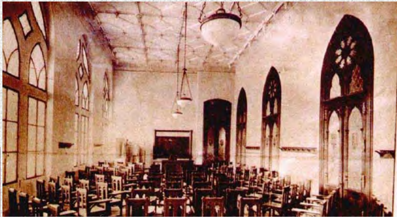
Aula (Revista El Arquitecto - 1926)
