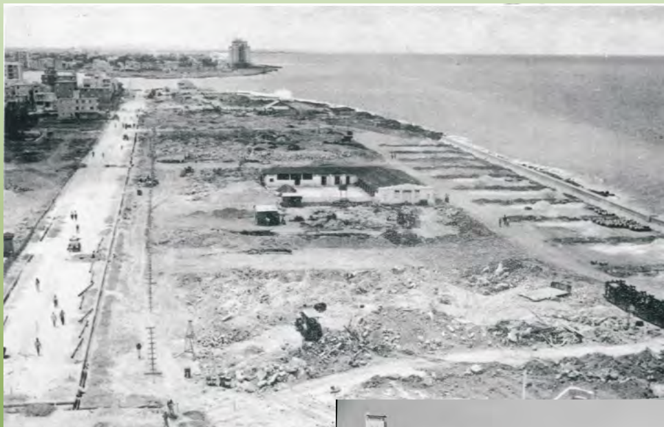
Construcción del último tramo del muro del malecón (1958)
